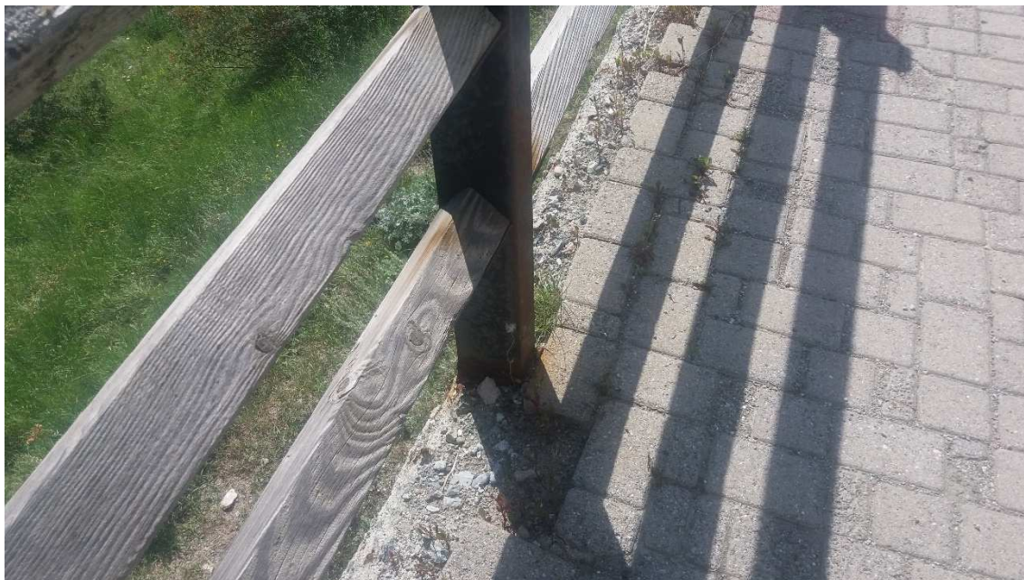
Foto 9 – Situazione di degrado ancoraggio recinzioni
