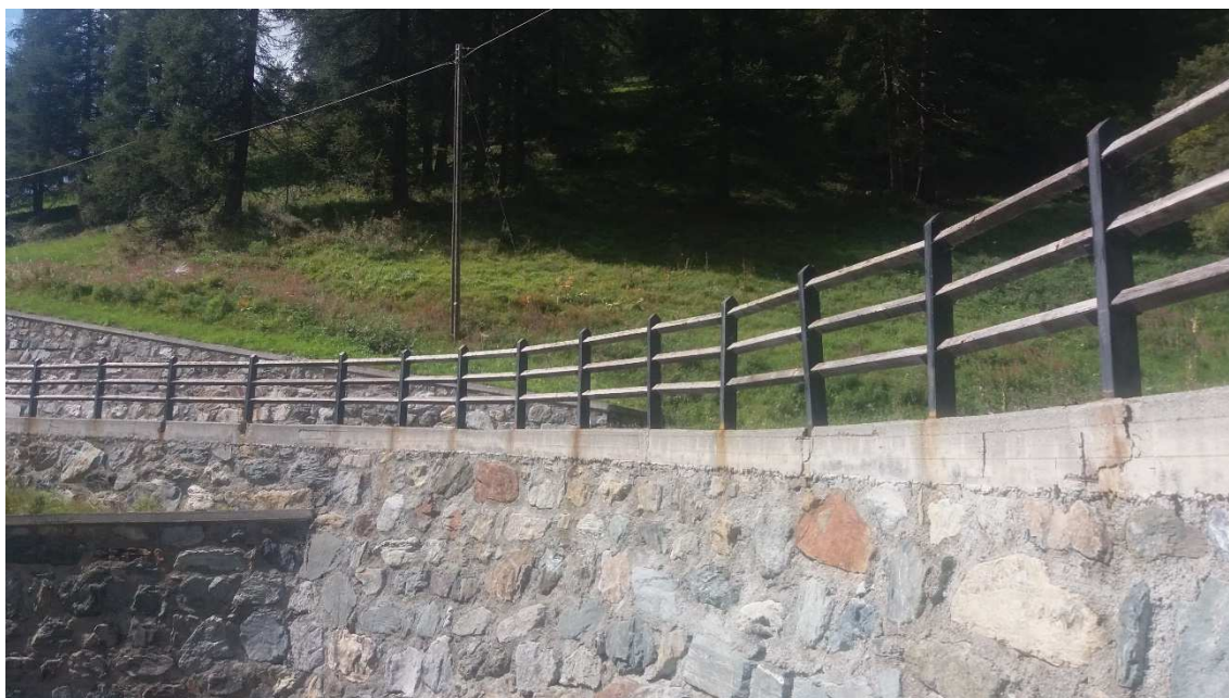
Foto 10 – Situazione di degrado cordolo di valle
